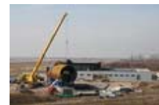
Anlieferung von Teilen für das neue Ausbildungszentrum der Werkfeuerwehr
