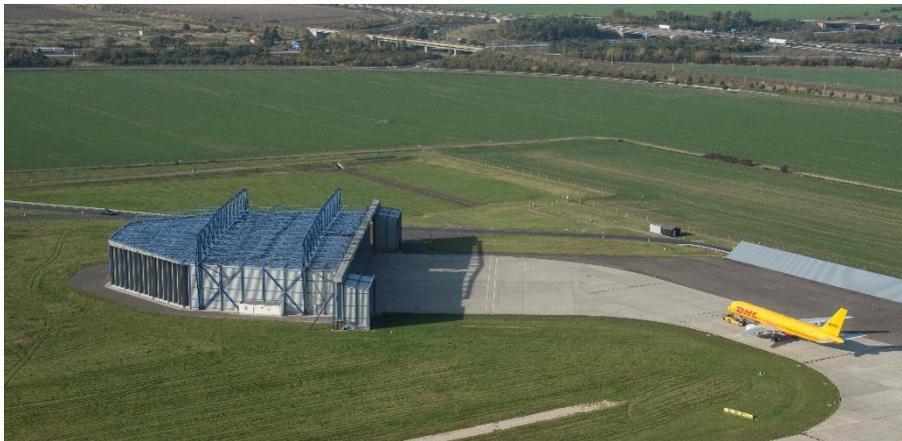
Die Halle ist einzigartig. Eine zweite, konstruktionsgleiche Halle existiert nicht. Mit einer Länge von 76 Metern, einer Breite von 90 Metern und einer Höhe von 22 Metern können in der Halle auch Triebwerke einer Antonow AN124-100, dem weltweit größten in Serie gebauten Frachtflugzeug, getestet werden.
